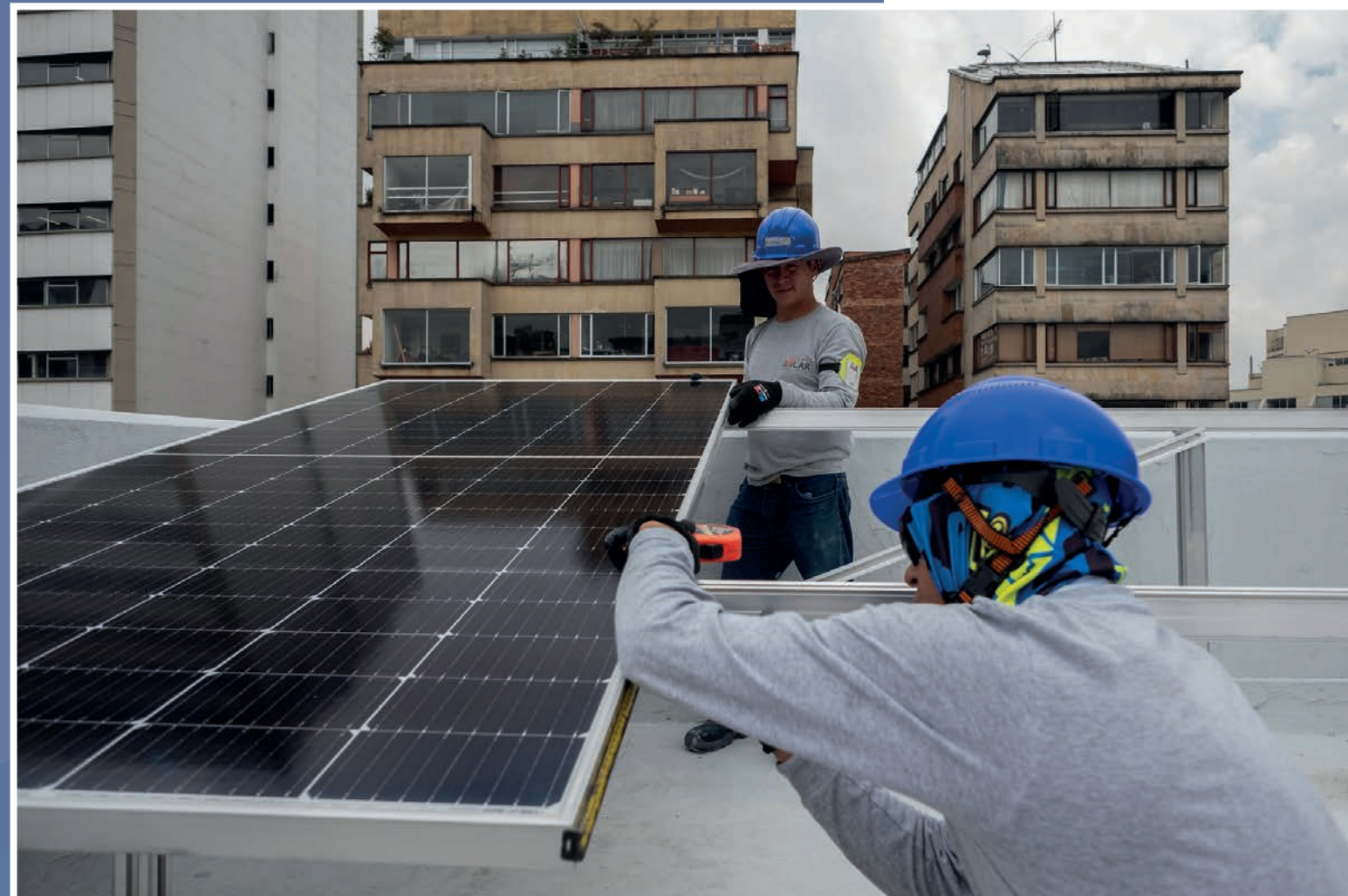
Instalación de paneles solares. Foto: Minambiente ▲
